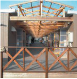
釜石市のコミュニティケア型仮設住宅。ケアゾーンはバリアフリーのウッドデッキ。向かい合わせに並んだ玄関は自然と挨拶を生み出す。
