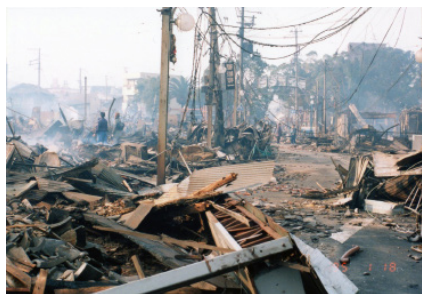
25 年前の神戸市長田区 (写真提供/神戸市)
